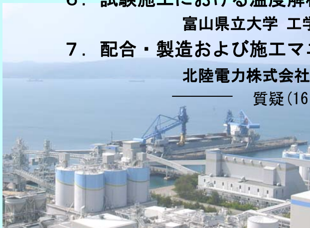
北陸電力株式会社七尾大田火力発電所(フライアッシュ貯蔵サイロ)
